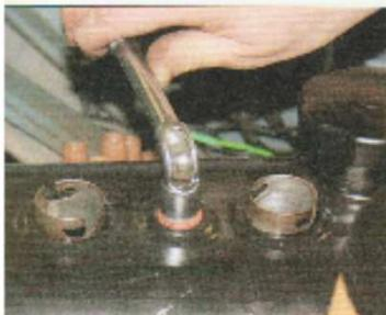
**40** Réaliser les joints étanchéité et les soudures sur mesure et serrage manuellement. Ici tout en cuivre, c'est un joint bague qui assure l'étanchéité. Il faut mieux procéder à un raccordage une fois le raccord en route faites avec des bagues d'accouplement.
